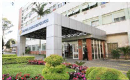
Reforma do Hospital Banco de Olhos de Porto Alegre
